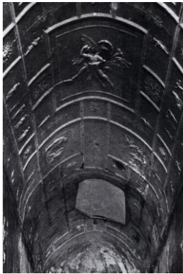
Basilica sotteranea Stuckreliefs am Tonnengewölbe des Mittelschiffs
